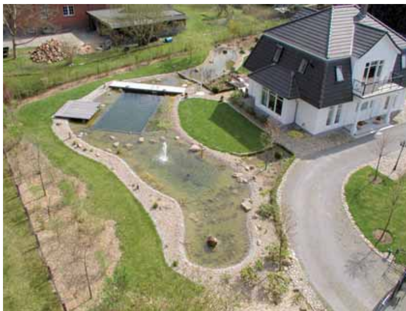
Schwimmteichanlage Gromatzki, Suderburg, mit Badebereich 4 x 8 m, 1,60 tief
