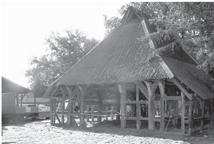
Das Haus Oldendorf am ursprünglichen Standort im Abbau.
