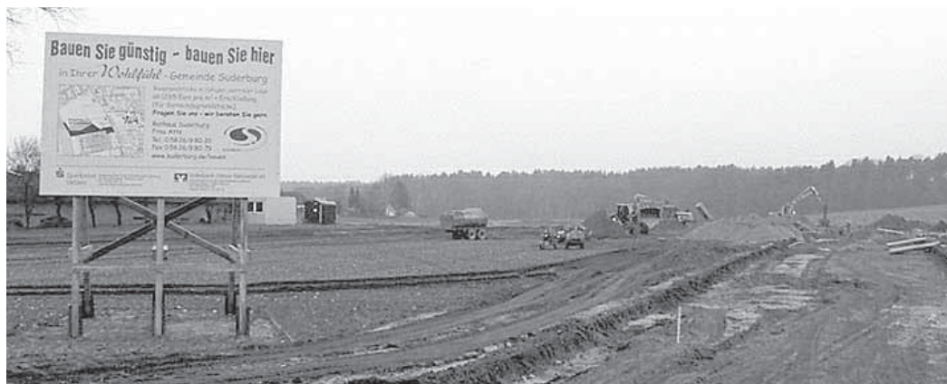
Zum Ende des vorigen Jahres begannen die Erschließungsarbeiten für das neue Baugebiet „Tannrähmblick“.
